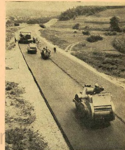
Una de las tantas carreteras construidas en gran parte con el aporte voluntario de la juventud de ambos sexos
