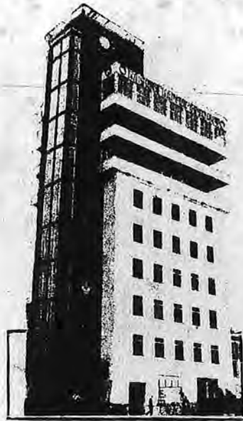
Una torre de hombres, de cemento armado, hecha en 40 días en el local de la exposición "Gesolei".
