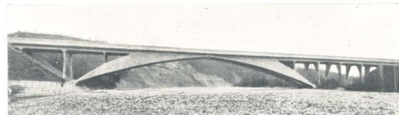
7. Puente de la Thur de R. Maillart. El puente apenas toca el suelo, característica ésta tanto del arte del ingeniero moderno como de la nueva plástica constructiva
