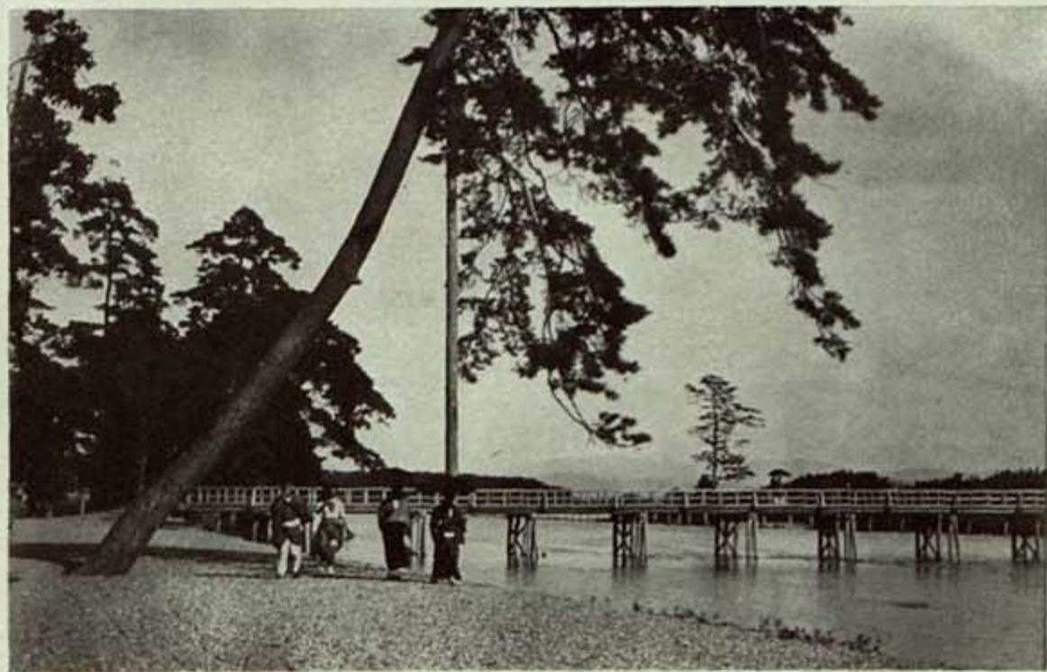
Un puente sobre un canal.
