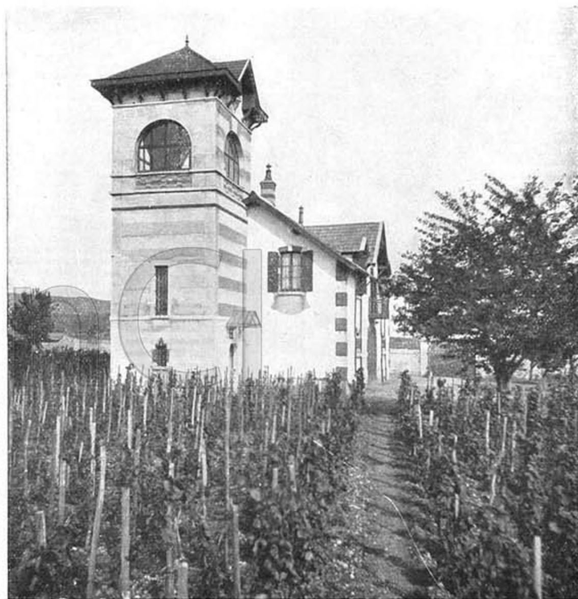
Château de la Tour au Clos de Vougeot
