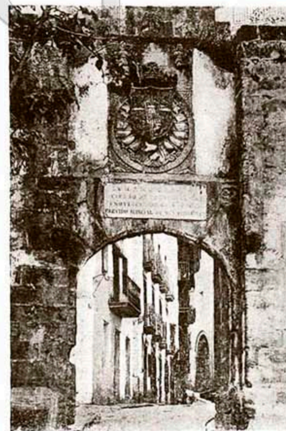
La Puerta Mayor de Fuenterrabia.
