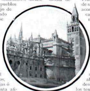
Un aspecto de la Giralda.
