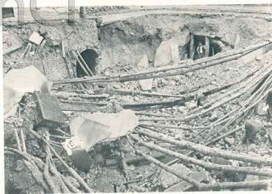
Vista de las excavaciones producidas por la tormenta, en el boulevard Haussmann.
