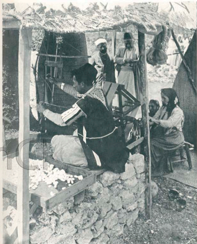
En el Norte de Siria. — La calada interior de los capullos hace difícil su transporte, y realizan el trabajo estas máquinas primitivas. El obrero busca el extremo del capullo, lo enrolla, y lo prepara para hilar la seda.
