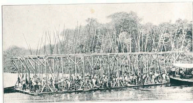
Preparación de las rocas para facilitar el dragado (1855-1858).
