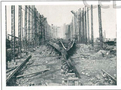
Los trabajos avanzan en 15 de Agosto del mismo año.
