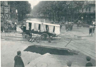
El pavimento abierto por las filtraciones de aguas en la Plaza de San Agustín. El coche de turistas emborinado en el suelo mojado. El agujero en que se precipitó un taxi-automóvil, prestando el "chauffeur" y una viajera.
