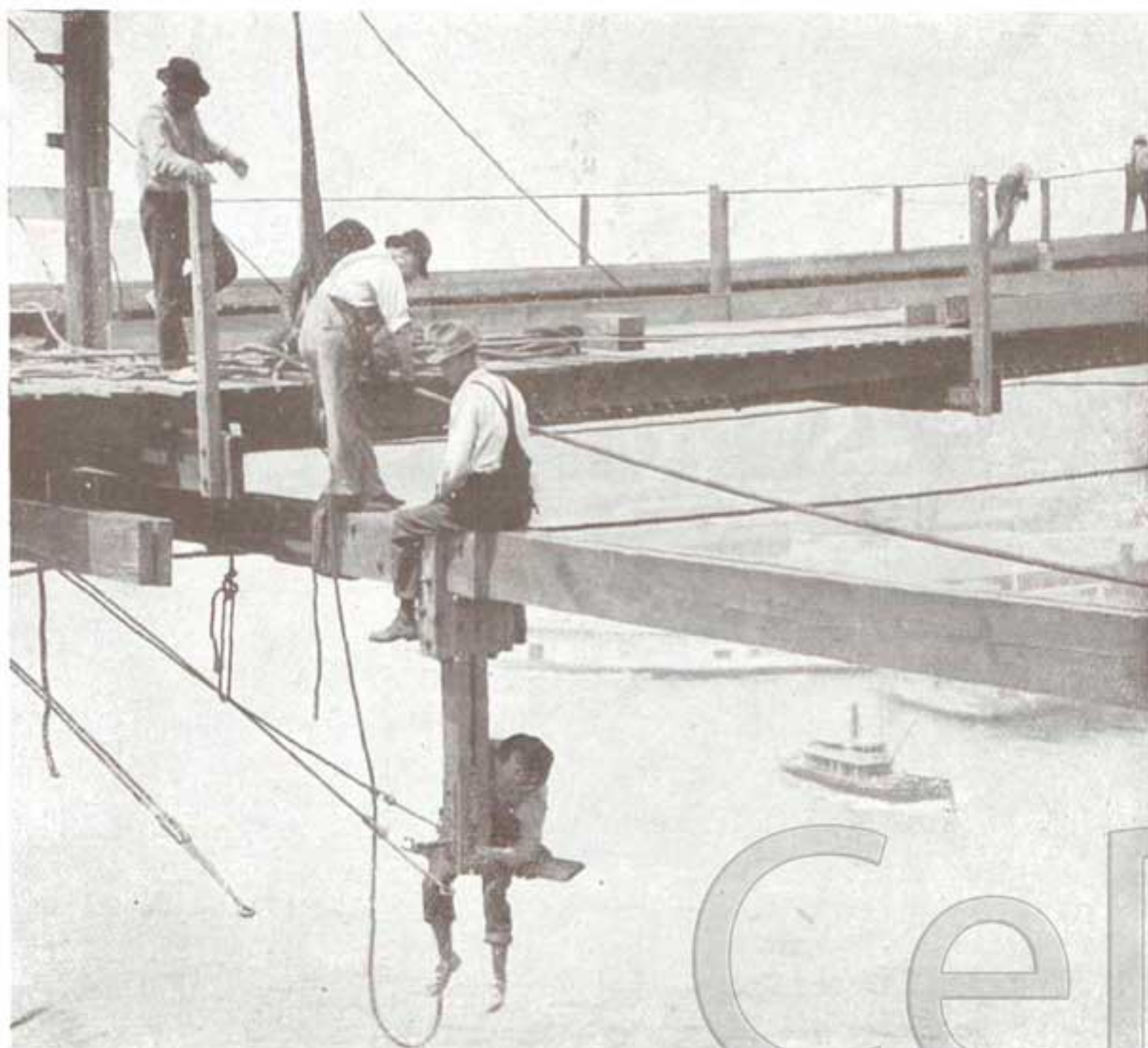
Carpinteros-mecánicos haciendo una delicada reparación en un puente de Nueva-York.
