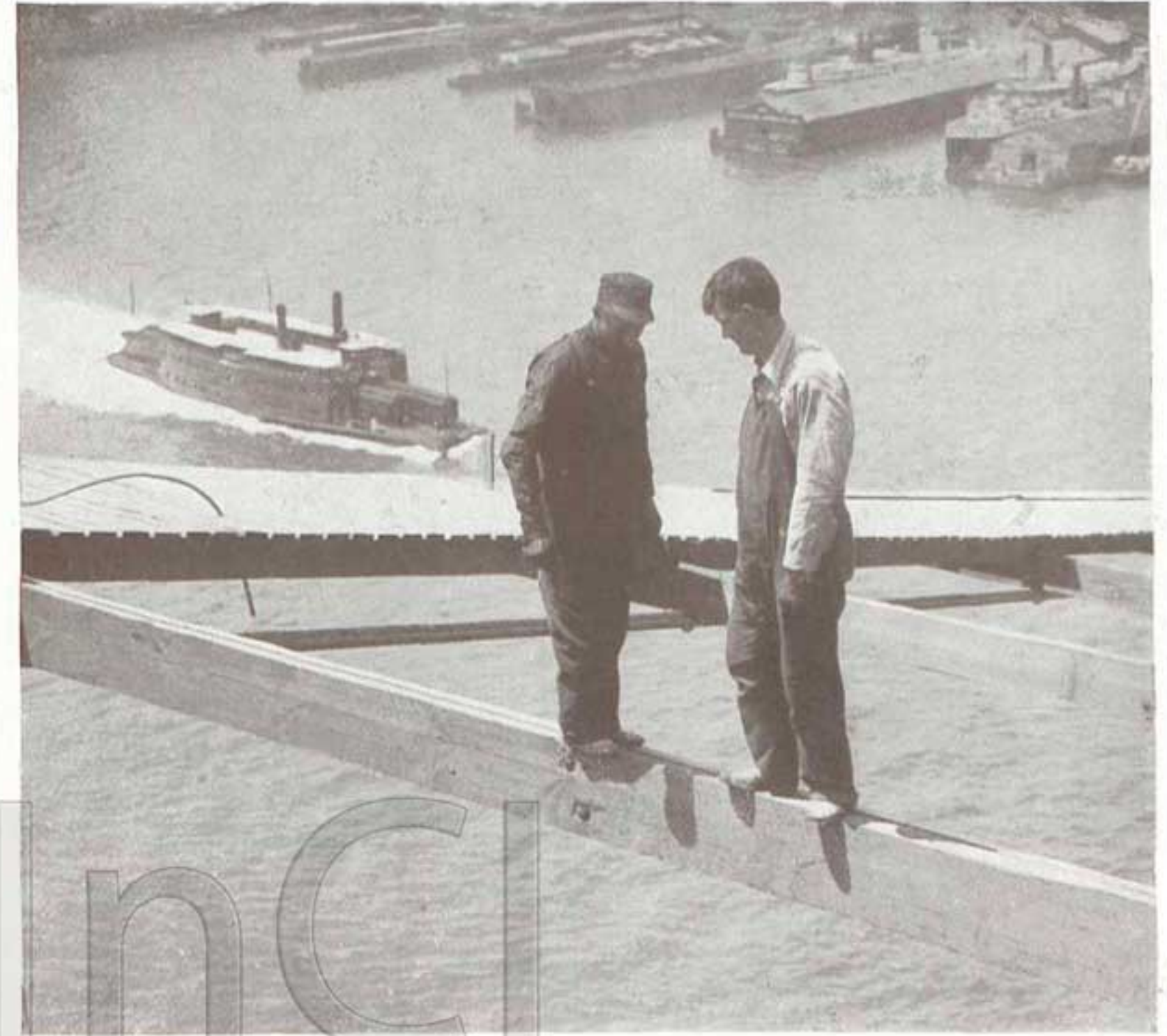
Sobre el Hudson, construyendo un puente a más de cien metros de altura.
