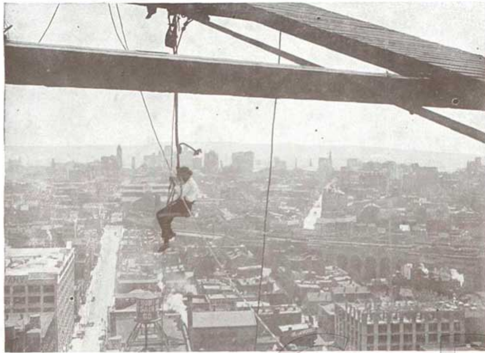
Viaje aéreo acompañando una viga de acero para la construcción de un rasca-cielos en Nueva York.
