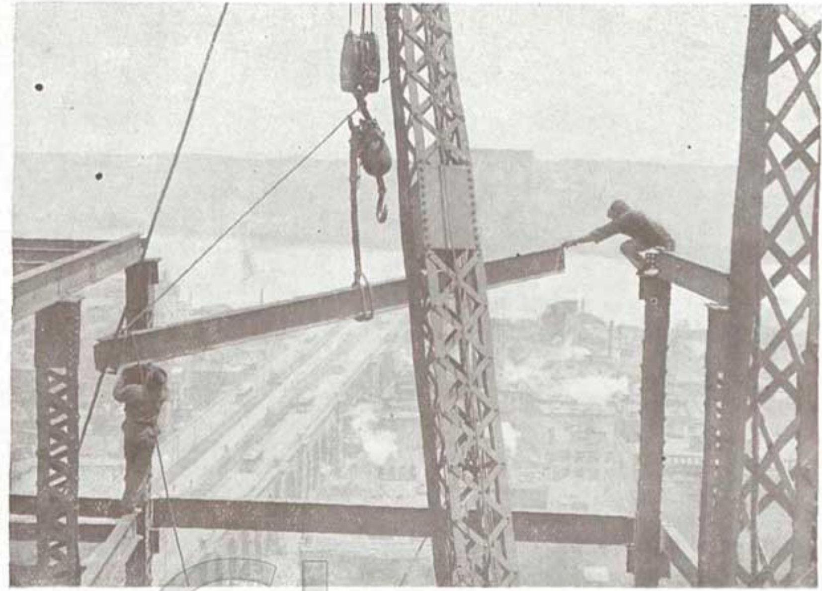
Llegada de la viga al piso 21 y colocación de la misma. Esta es la operación que ha producido más víctimas.
