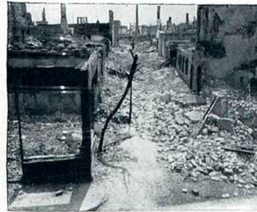
Aspecto de una calle en Stambul, después del incendio. Las ruinas del clásico barrio tienen un aspecto desolado y lúgubre.
