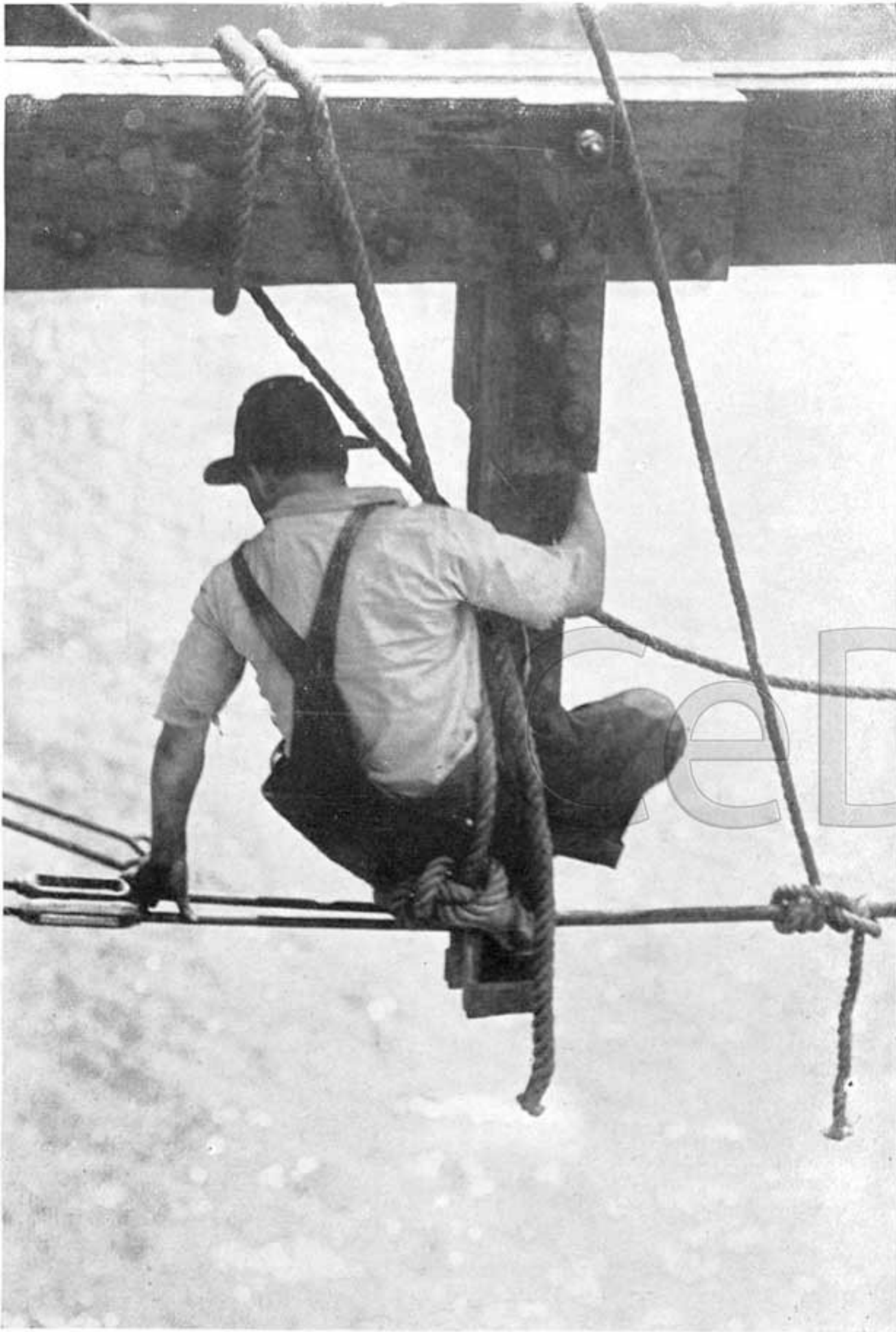
Este obrero norteamericano bien puede decirse que tiene la vida en un hilo, pues si alguno de los cables que le sostienen en el vacío se rompiese, su muerte sería segura.
