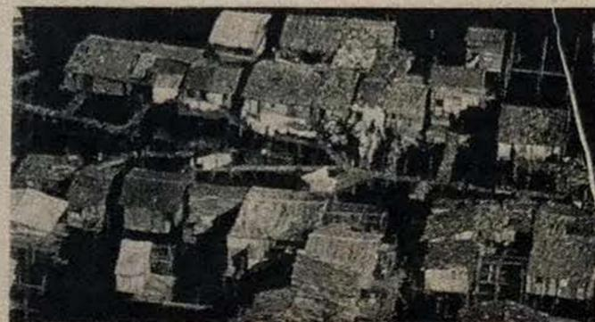
Conjuntos residenciales construidos en terreno de erosión sin cimientos o envidados especiales. Tejas que vuelan con el viento. Cables eléctricos expuestos, filtración de agua por las paredes, pisos que se agrietan en poco tiempo, entablados sueltos. Falta de basureros, de iluminación y de alcantarillado decente. Sólo en el año de 1971, fueron financiadas en Brasil 767 mil casas de este tipo.
