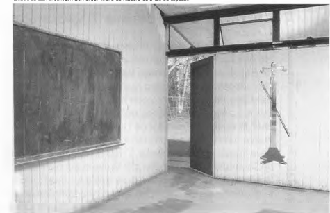
Escuela en Barrancon, San Bernardo; muro de madera de 3 cm de espesor
