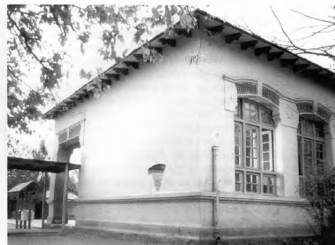
Escuela Santa Rita, Pirque; figura en muro de ladrillo de 50 cm espesor
