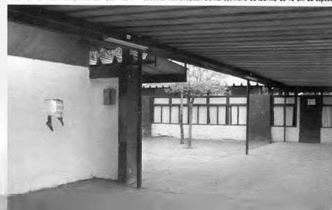
Escuela Alemana, San Bernardo; muro de ladrillo de 15 cm de espesor
